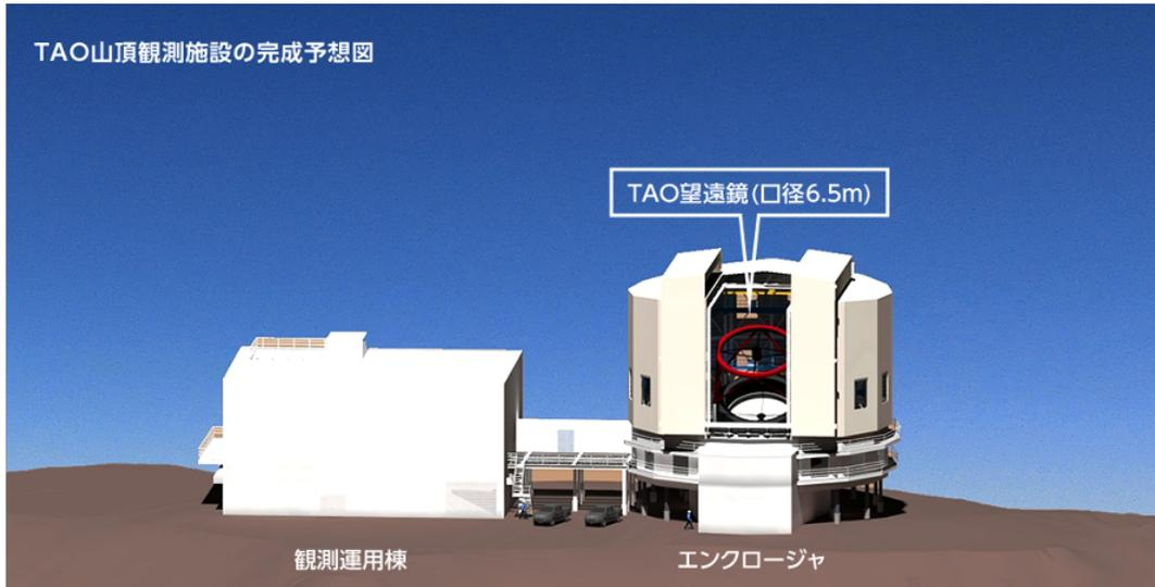
図 1.2: TAO の山頂観測施設の完成予想図。観測運用棟 (左) と望遠鏡ドーム (右) の二つが橋でつながった構造をしている。
